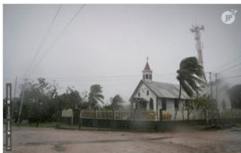
Telcor informa sobre afectaciones en las telecomunicaciones provocadas por el huracán Iota
